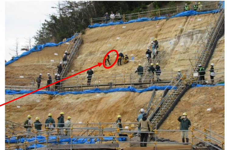
北西法面(上段) 現場確認:2023年12月14日
